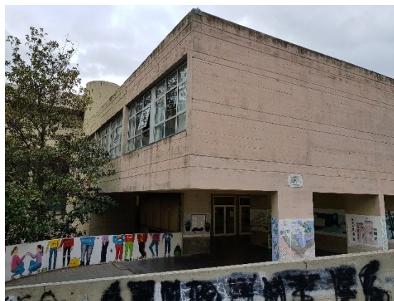
Figura 1.1 - Vista della facciata esposta a nord
