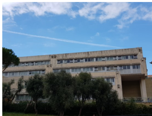
Figura 8.1 - Particolare delle facciate delle aule su cortile interno
