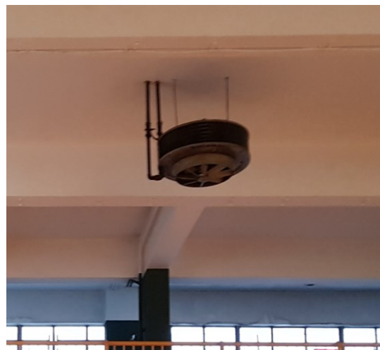
Figura 4.6 - Particolare degli aerotermi installati nella palestra
