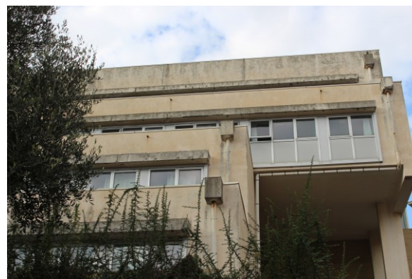
Figura 8.3- Particolare dei solai disperdenti
