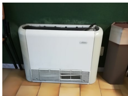
Figura 8.7 - Particolare dei radiatori esistenti
